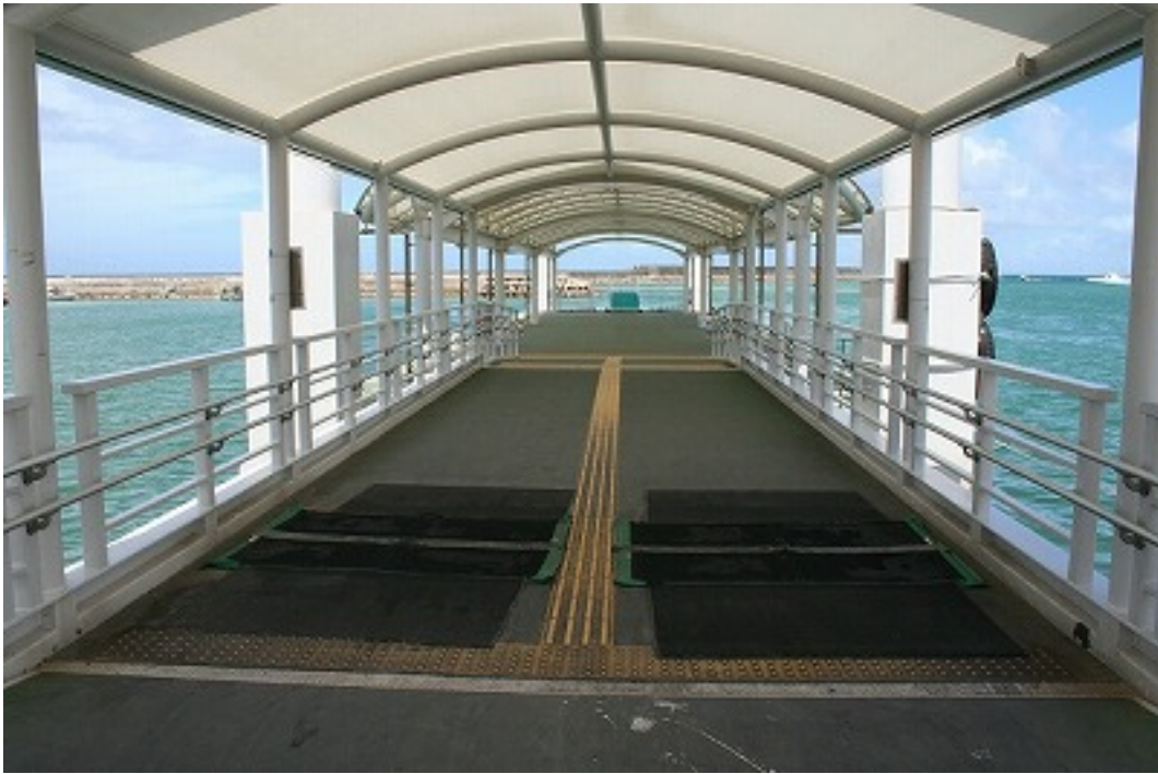
写真1 上原地区栈橋
