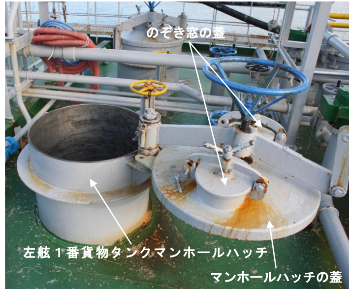
(写真 2.5-1 左舷1番貨物タンクマンホールハッチ)
